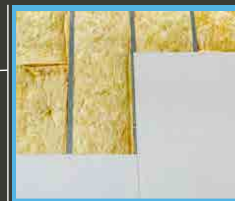
Cloisons placostil 72 mm avec 45 mm d'isolant
