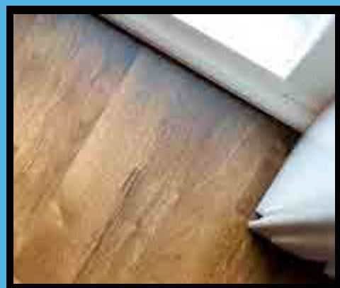
Parquet stratifié sur chape avec isolant phonique
